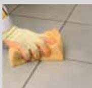
Gâcher **weber.color premium** à 1,1-1,25 litres d'eau propre par sac de 5 kg, manuellement ou bien avec un malaxeur électrique lent (500 rpm) jusqu'à obtenir une masse homogène et exempte de grumeaux. Laisser reposer la gâchée pendant 2 minutes.
